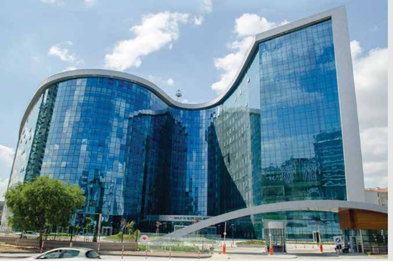
DSİ Genel Müdürlüğü Hizmet Binası, Ankara
